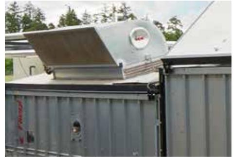
Dachhute mit Gebläse und Wärmetauschereinheit
