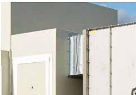
Verbindung zum Luftwäscher mittels Segeltuchstützen
