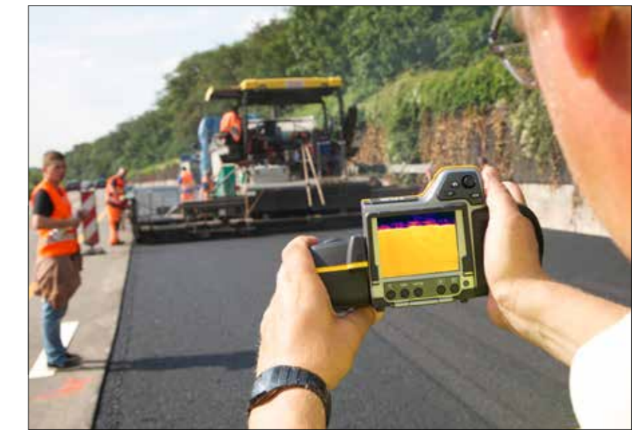
Gleichmäßige Temperatur und optimale Korngrößenverteilung ergeben hier eine qualitativ hochwertige Asphaltdecke.
