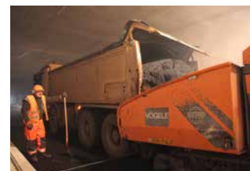
Baustelle in München, Luise-Kisselbachstr Besonderheit: Einsatz im Tunnelbereich mit temperaturabgesenktem Asphalt
