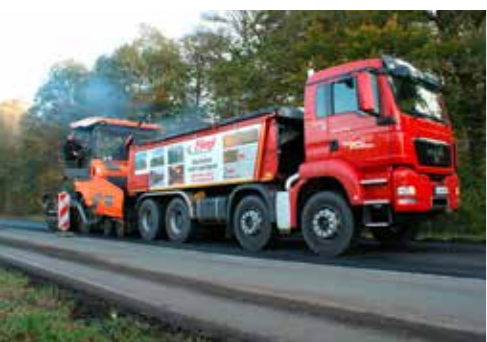
BV Bielefeld Besonderheit: Asphaltieren im Alleebereich
