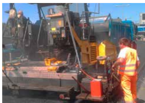
Autobahn A 100 in Berlin, meistbefahrenste Straße Europas Besonderheit: Einbau von Porous Mastix Asphalt (PMA)
