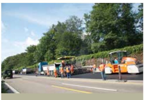
Autobahnstück A3 bei Frankfurt Besonderheit: Einbau neben z.T. stark fließenden Verkehr
