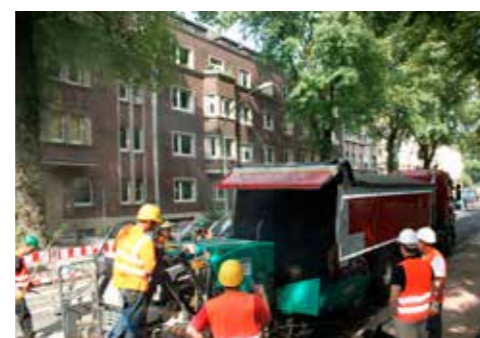
BV Duisburg Besonderheit: Asphaltieren in der Innenstadt mit vielen Hindernissen. Teilladungen sowie das Beschicken von Gehwegfertigern
